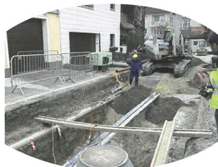
Sanierungen des Kanalnetzes - ein sehr kostenintensiver Faktor
